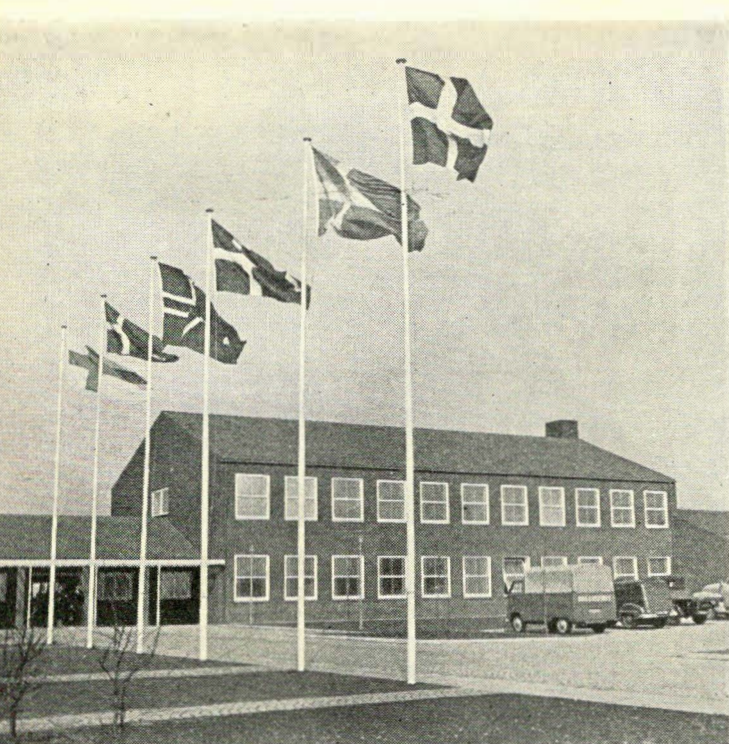
Esbjerg Højskoles skolebygning.
